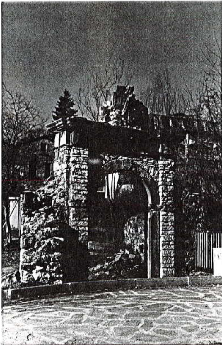
Portale d'ingresso alla 'Peschiera' (intervento in corso) contributo 1° parte: Fondazione Cassa di Risparmio di Parma
